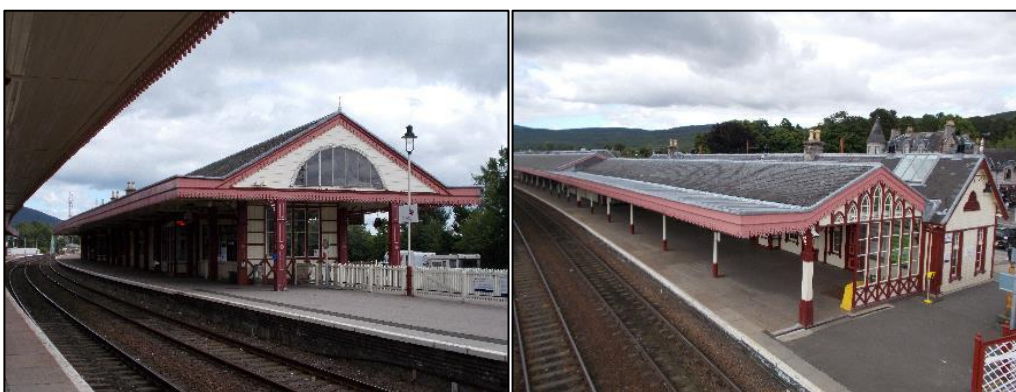
Photographs 10 & 11 Aviemore Station (site 62)
